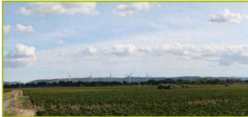
Figure 12 : comparatif entre les éoliennes simulées (en haut) et réalisées (en bas)
